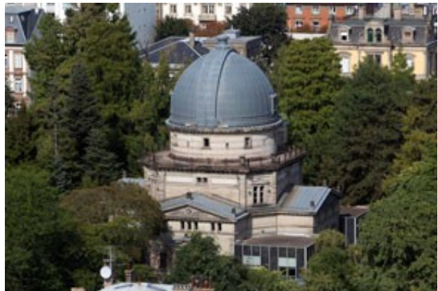
Figure 1 : bâtiment de la coupole
